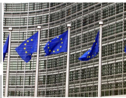
Штаб-квартира ЕС в Брюсселе
